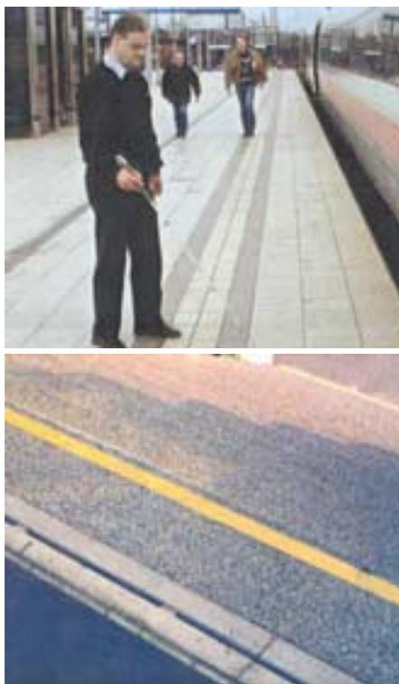
auch als Schutzlinien beispielsweise an Bahnkanten eingesetzt. Es ist aber dann besonders wichtig, dass diese auch quer zur Linienrichtung mit dem Langstock problemlos erfasst werden können.
