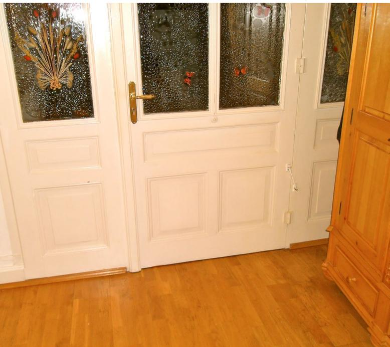
Die Magnet-Dichtung von ALUMAT mit nur einer Magnetschiene für Innentüren funktioniert bei Schreinermeister Heiner Rink seit über 25 Jahren noch wie am ersten Tag.
