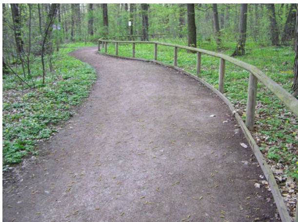
Abb. 23: Wassergebundene Decke auf dem ‚Sport- und Wanderweg für Menschen mit Behinderung‘ im Steigerwald bei Erfurt.
