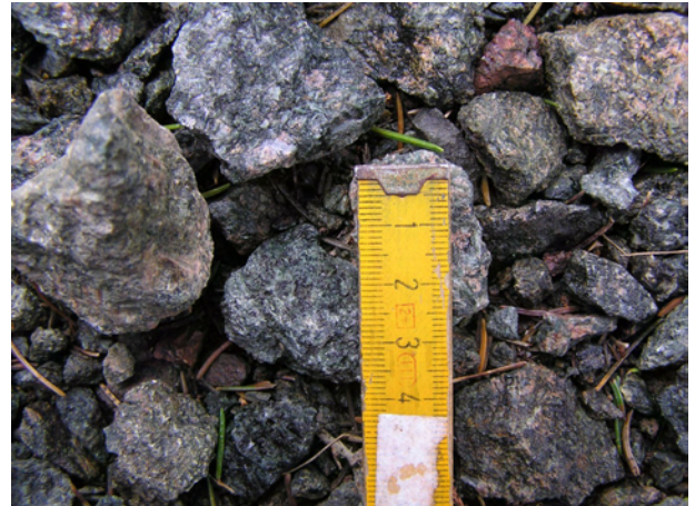
Abb. 26: Zu grober Schotter auf einem Wanderweg. Wird Schotter zur Festigung der Deckschicht verwendet, so sollte dieser einen Durchmesser von 1 cm nicht überschreiten. Scharfe Steinkanten können zudem das Pannenrisiko für Rollstuhl- und Radfahrer erhöhen.
