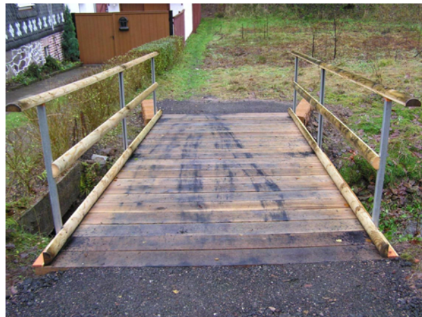
Abb. 13: Brücke mit Radabweisern
