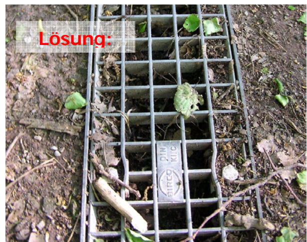
Abb. 32: Gitterabdeckung einer Entwässerungsrinne
