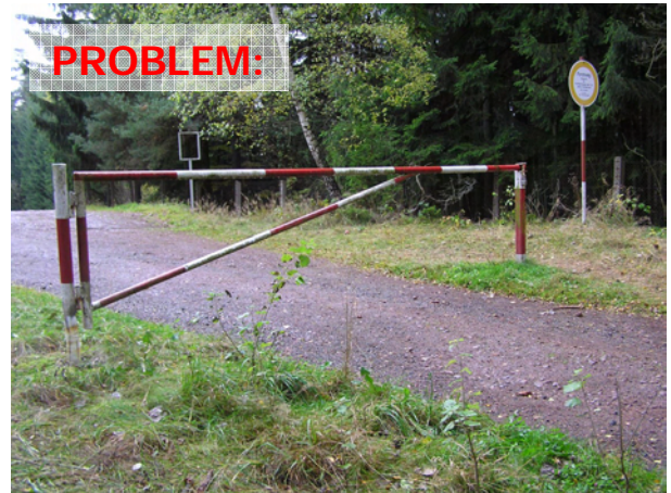
Abb. 33: Bei dieser Forstschranke könnte problemlos eine ausreichend breite und befestigte Umgehungsmöglichkeit errichtet werden.
