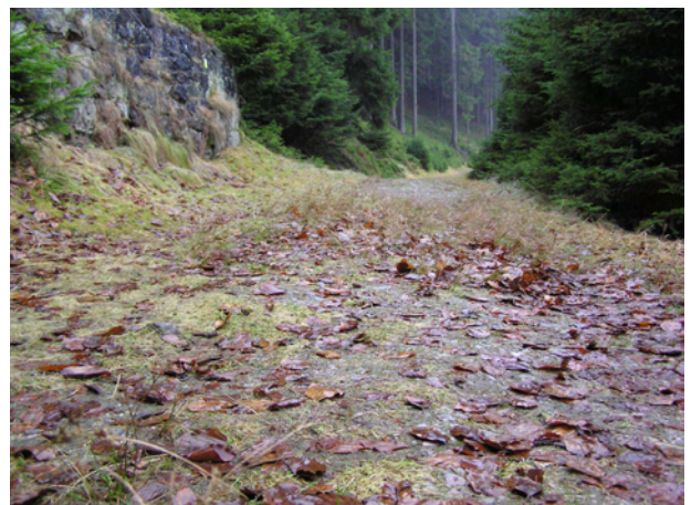
Abb. 24: Gefahr des Verkrautens bei wassergebundenen Decken. Bei Nässe wird dadurch die Nutzung erheblich erschwert.
