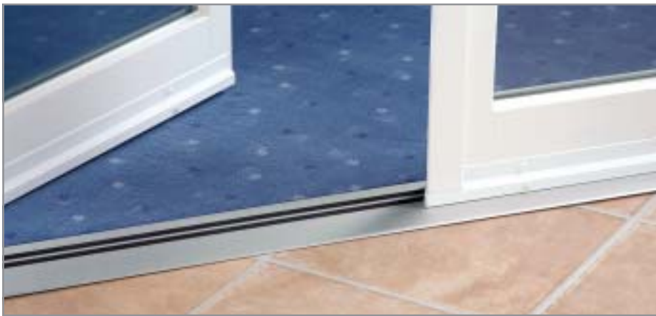
Bei Einbau von Magnettoppeldichtungen werden Stolperschwellen gänzlich vermieden.
