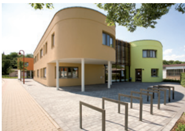
Abb.6 Straßenansicht des MVZ in Rothenburg.
