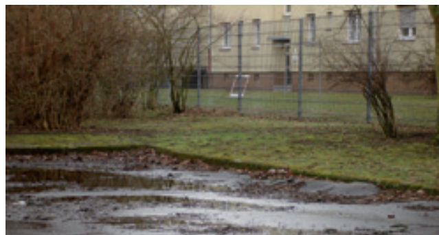
Abb.7 Unebener Bolzplatz, der ständig unter Wasser steht, im Planungsgebiet des zukünftigen Bürgerparks
