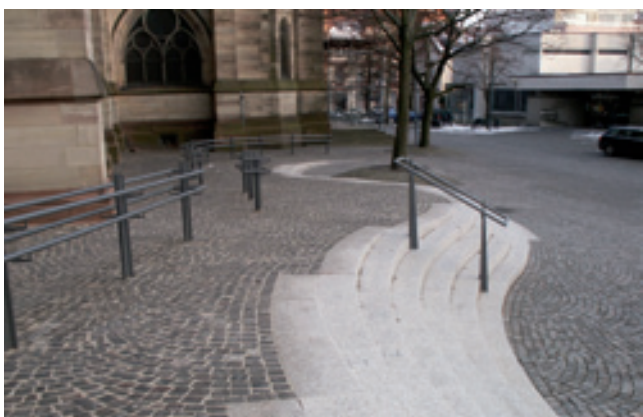
Abb.4-5 Barrierefreie Erschließung Gedächtniskirche Speyer
