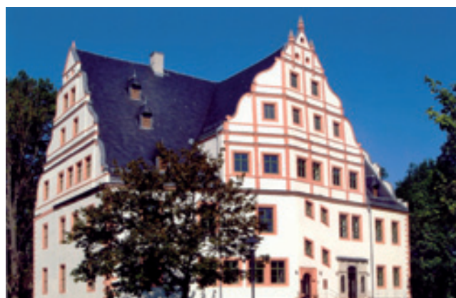
Abb.9-10 Barrierefreie Erschließung Renaissanceschloß Ponitz
