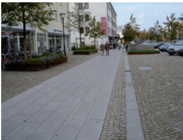
Abb.8-9 Die Lösung: RINN Magnum in historischen Innenstädten
