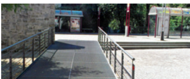
Abb.5-6 Kleinpflaster und Gehbahn an der Langen Brücke/Rampe am Brühler Garten
