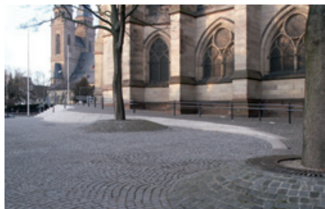
Abb.6-7 Barrierefreie Erschließung Gedächtniskirche Speyer
