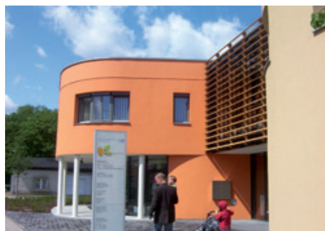
Abb.7 Eine klare Eingangssituation erleichtert die Orientierung.
