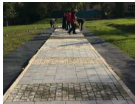
Abbildung 105: Teststrecke im Außenraum im abgetrockneten Zustand
