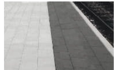
Die Kante zwischen hellem und dunklem Betonstein reicht nicht aus. Sie wird nicht als Sicherheitslinie wahrgenommen.
