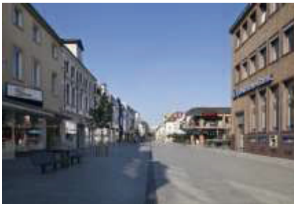
Abbildung 150: Entwässerungsrinne als Leitelement mit Beschattung in der Fußgängerzone Bergisch-Gladbach, Foto: Margot Gottschling
