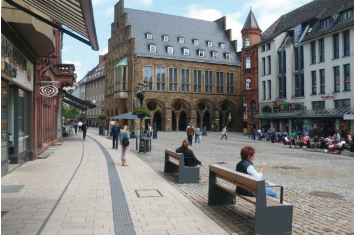
Abbildung 13: Fußgängerzone in Minden mit hellem Grundbelag und deutlich kontrastierendem dunklem Leitelement (Bodenindikator)
