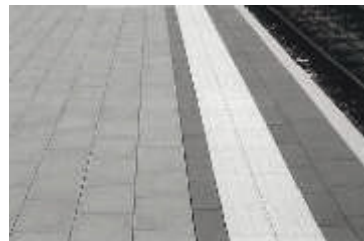
Sicherheitslinie aus Betonstein. Helligkeitskontrast durch dunklen Begleitstreifen.
