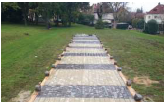
Abbildung 104: Teststrecke im Außenraum mit ausgeprägten Trocknungsbereichen
