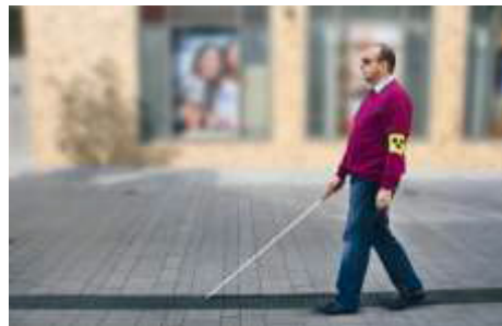
Abbildung 151: Abdeckung der Entwässerungsrinne als Leitelement für Blinde und Sehbehinderte, Foto: www.birco.de
