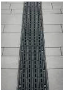
Abbildung 151: Abdeckung der Entwässerungsrinne als Leitelement für Blinde und Sehbehinderte, Foto: www.birco.de
