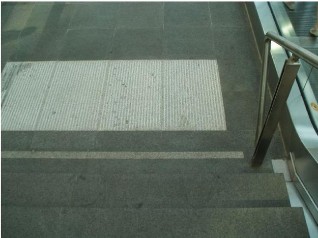
*Scheinstufe, vorkragendes Handlaufende, ungenügende Stufenkantenmarkierung (PW)*
